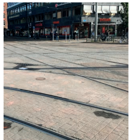
Spårområde med markbetong vid Järntorget i Göteborg, bild: Göteborgs stad
