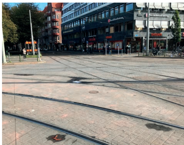
Överfart med markbetong vid Järntorget i Göteborg, bild: Göteborgs stad
