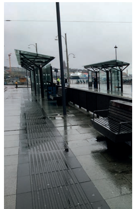
Plattform med taktila markplattor vid Stenpiren i Göteborg, bild: Afry
